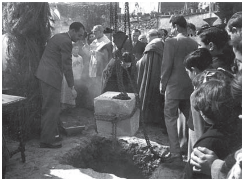
Col·locació de la primera pedra del Centre Parroquial
