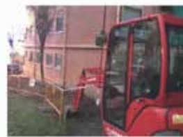
Obra civil y verticales
