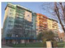
Rehabilitación de fachadas
